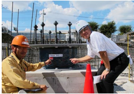
①消防本部庁舎免震構造視察（8月29日）
