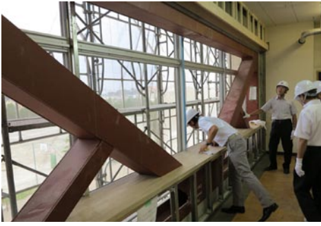
⑤耐震補強工事視察（8月17日）
