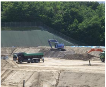
写真(左)は、搬入された廃棄物(焼却灰)に覆土するコンボ。また、他に敷地内には、彩の国資
