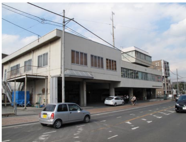
老朽化が進む消防本部（ふじみ野市）
