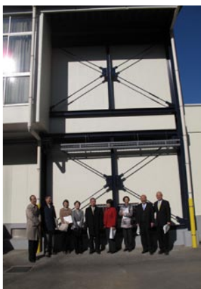
耐震化された東中学校体育館
