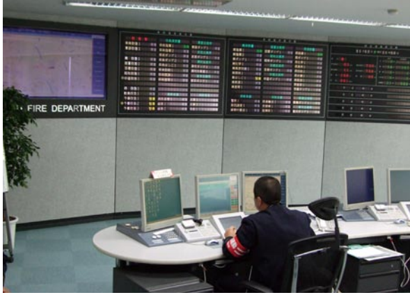
甲府市消防本部高機能指令センター
