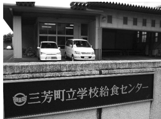
老朽化の進む学校給食センター
