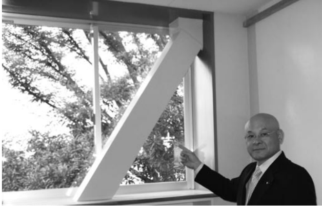
耐震補強の鉄筋の筋交い：ブレース（三芳東中学校）
