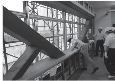
⑥耐震補強工事完了
