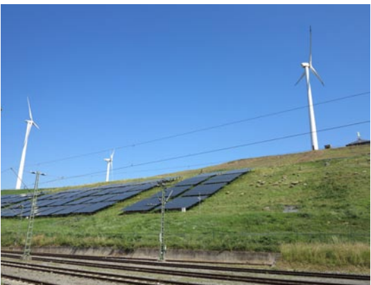
エネルギーの丘（太陽光発電、風力発電）
